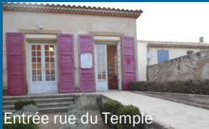
Entrée rue du Temple
