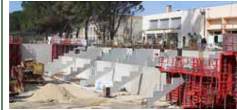
Complexe sportif et culturel : les gradins sortent de terre en février 2017.
